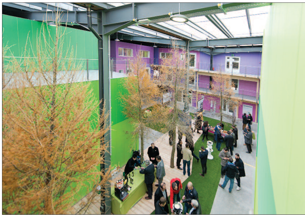
Des conteneurs protégés par une enveloppe non chauffée ou boxes in a box, comme l'a imaginé Beat Vonlanthen. MÉLANIE ROULLER
