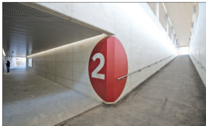
L'installation de marquises augmente le confort des usagers et permet la construction de rampes plus pentues. MÉLANIE ROULLER
